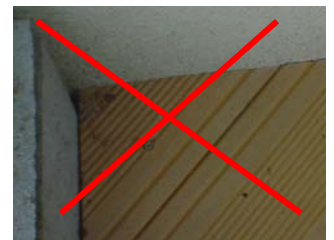
Laat een afstand van 5mm tussen de planken en 15 mm tussen plank en muur.
