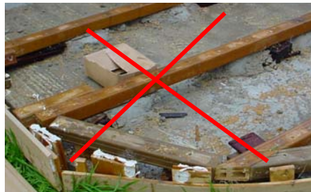
Minstens 10mm uitzetvoeg tussen de balken houden
