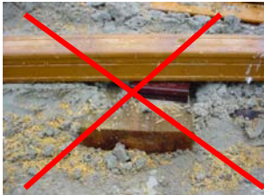
De balken niet inbedden in beton
