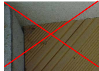
Laisser un joint de dilatation de 5 mm entre les lames et de 15 mm par rapport à un mur
