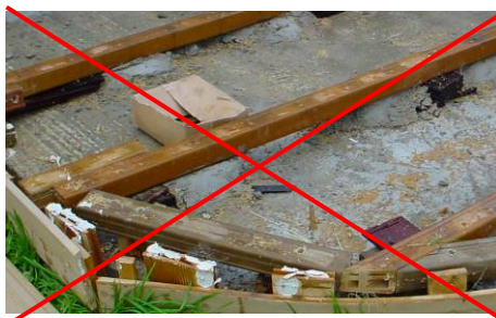
Respecter les joints de dilatation de 10 mm entre lambourdes
